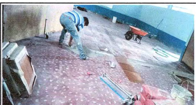
FOTO 4: MEJORAMIENTO DE TORTA DE CONCRETO EN MAL ESTADO POR PISO CERAMICO MEJORANDO LAS CONDICIONES DE LAS AULAS.
