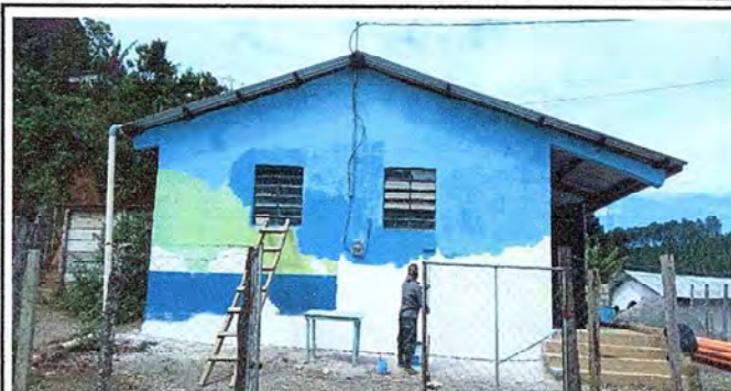
FOTO 8: MEJORAMIENTO DE PINTURAR INTERIOR Y EXTERIOR, DEBIDO AL DETERIORO DE LA MISMA.
