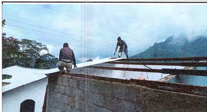
FOTO 1: SUSTITUCION DE LAMINA ACANALADA EN MAL ESTADO POR LAMINA TROQUELADA (COCINA, BODEGA Y AULAS).
