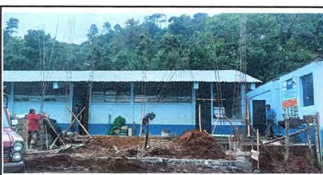
FOTO 12: CIMENTACION Y MONTAJE DE ARMANDURA DE HIERRO PARA MEJORAMIENTO DE PAREDES DE LAMINA POR BLOCK FORMAL, MEJORANDO LAS CONDICIONES DEL AMBIENTE ESCOLAR.
