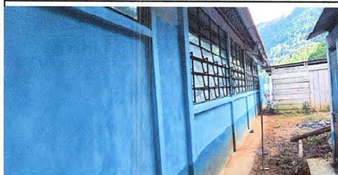
FOTO 7: MEJORAMIENTO DE PINTURAR INTERIOR Y EXTERIOR, DEBIDO AL DETERIORO DE LA MISMA.
