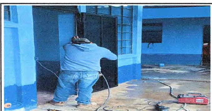
FOTO 6: SUSTITUCION DE PUERTAS DE METAL EN MAL ESTADO POR PUERTAS NUEVAS DE LAMINA PRENSADA CON SU RESPECTIVO PASADOR Y CANDADO (AULAS).
