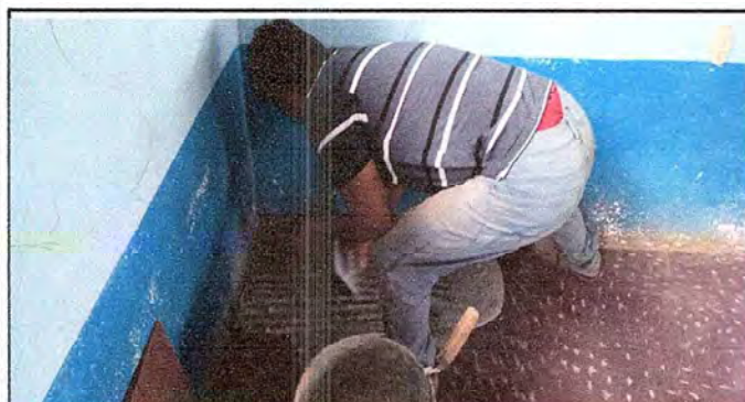
FOTO 3: MEJORAMIENTO DE TORTA DE CONCRETO EN MAL ESTADO POR PISO CERAMICO MEJORANDO LAS CONDICIONES DE LAS AULAS.
