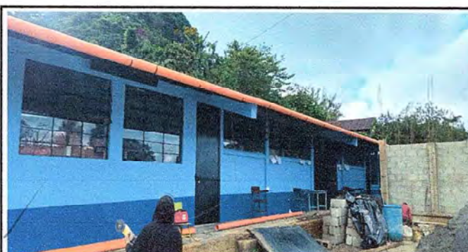
FOTO 10: INSTALACION DE TUBERIA Y PESCANES PARA MEJORAR LA CAPTACION DE AGUA PLUVIAL.
