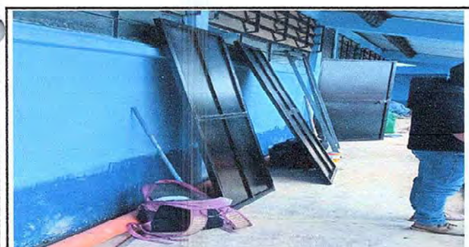
FOTO 5: SUSTITUCION DE PUERTAS DE METAL EN MAL ESTADO POR PUERTAS NUEVAS DE LAMINA PRENSADA CON SU RESPECTIVO PASADOR Y CANDADO (AULAS).
