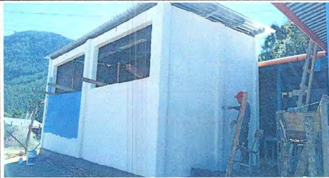
FOTO 13: MEJORAMIENTO DE PAREDES CON CERNIDO A BASE DE MONOCAPA PARA MAYOR DURABILIDAD DE LA OBRA.
