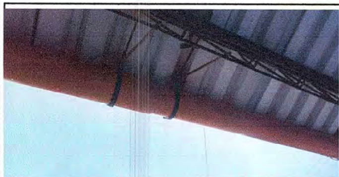
FOTO 9: INSTALACION DE TUBOS DE PVC DE 4" PARA MEJORAR LA CAPTACION DE AGUA PLUVIAL.
