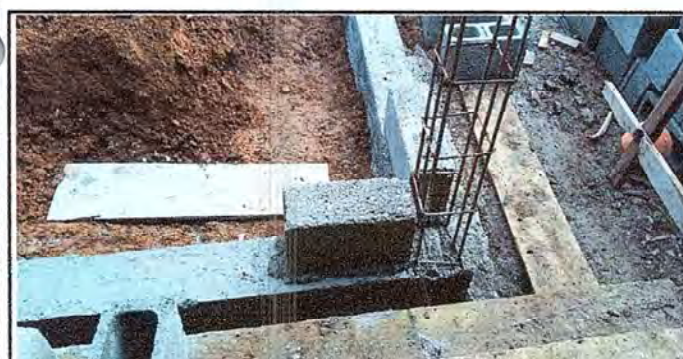
FOTO 11: CIMENTACION Y FUNDICION DE ZAPATAS PARA LA SUSTITUCION DE PARED DE LAMINA POR BLOCK FORMAL.
